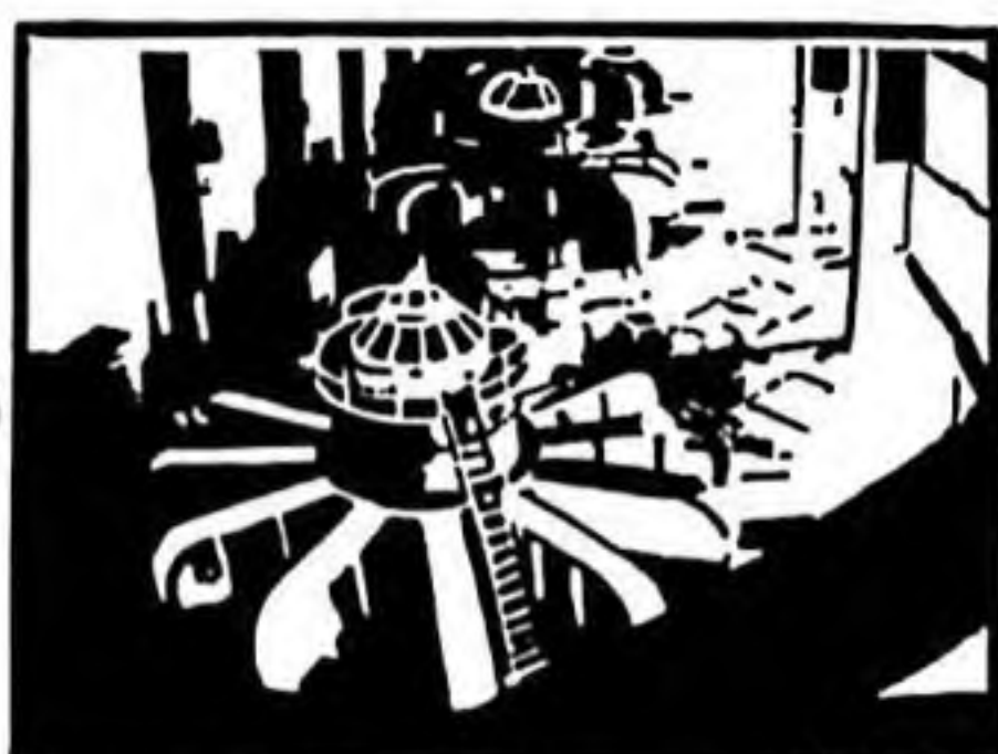
UNA GRAN CENTRAL HYDROELECTRICA
