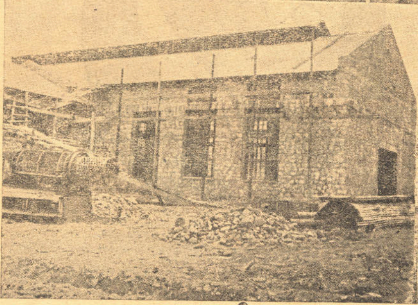
მშენი —საჭირო რკინის გზის მშენებლობაზე სამონტაჟო სამუშაოები (სადგ. ტყვარჩელი); ტყვარჩელის მშენი—150 ცხ. ძალის დიზელის დადგმა ელსადგურზე. დადგმა აწარმოებენ დამკვერელები აშხ. სლესკინი და ფასნავტი. მშენი —ტყვარჩელის ელსადგურის შენობა, ამ სადგურის ძალისგება 900 კილოვატს უდრის; გენერატორების დადგმა ტყვარჩელის ელსადგურზე. მუშაობას აწარმოებენ დამკვერელები აშხ. სოკოლოვი და გრუშაძე.
