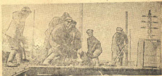
ბაჭადა აშენებს ბეტონს სანაპირო ქუჩის საერდენი კედლისათვის.
