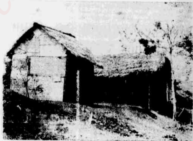
Muitos barracos, como estes poderão ser destruídos pois foram construídos em perímetro urbano, até mesmo ali no Forte de São João
