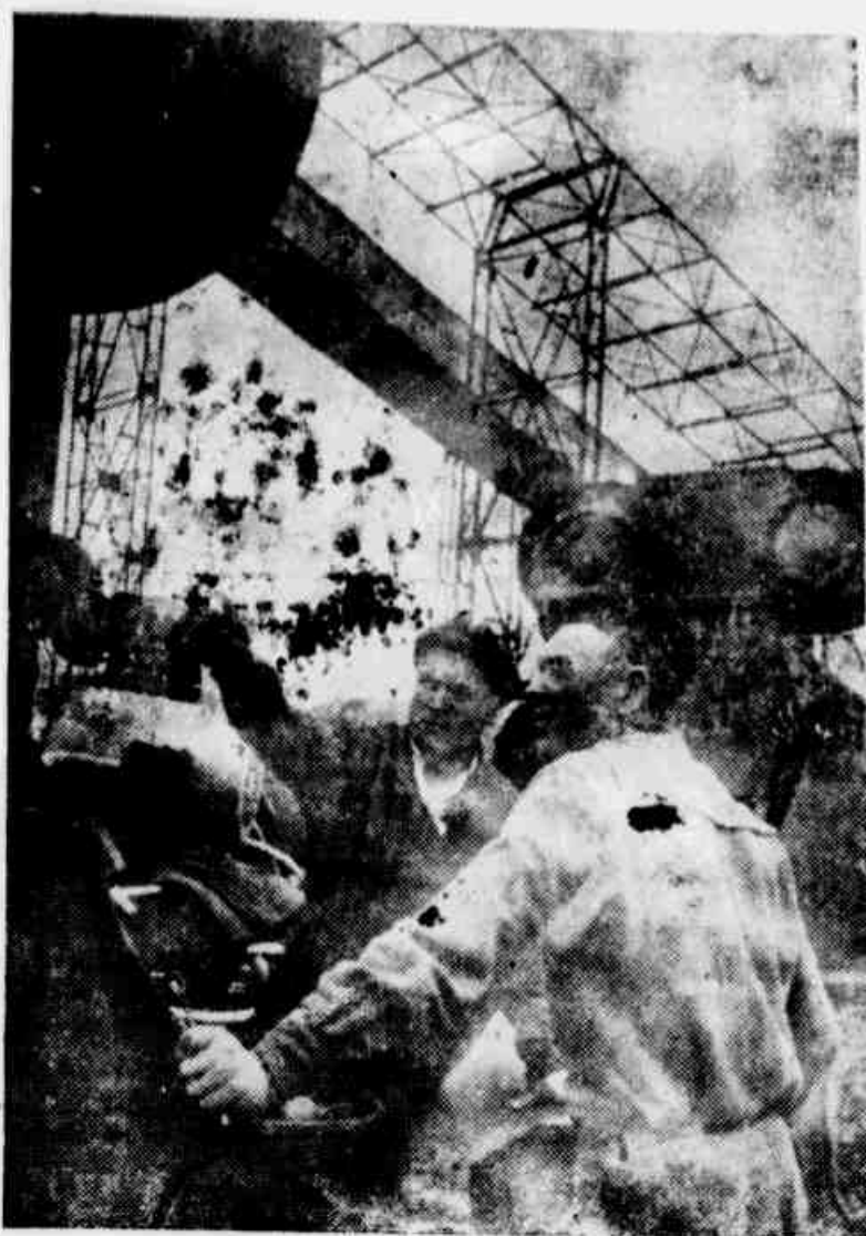
DOIS MONTADORES DE uma fabrica de elemento armado examinam mecanismos recém-chegados às obras da central hidroelétrica de Stalingrado, sobre o Volga. No rio Volga existem muitas grandes centrais hidroelétricas e dezenas de outras estão em construção. O aumento ininterrupto e gigantesco da produção de energia elétrica permite o desenvolvimento impetuoso da industria e de toda a economia nacional da União Soviética
