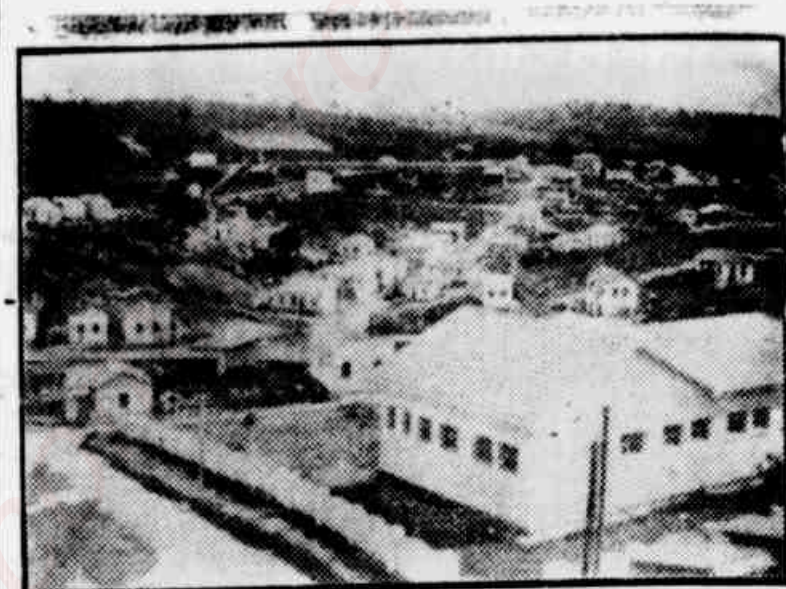
Vista geral de Nova Venécia, destacando-se as construções novas que caracterizam a cidade
