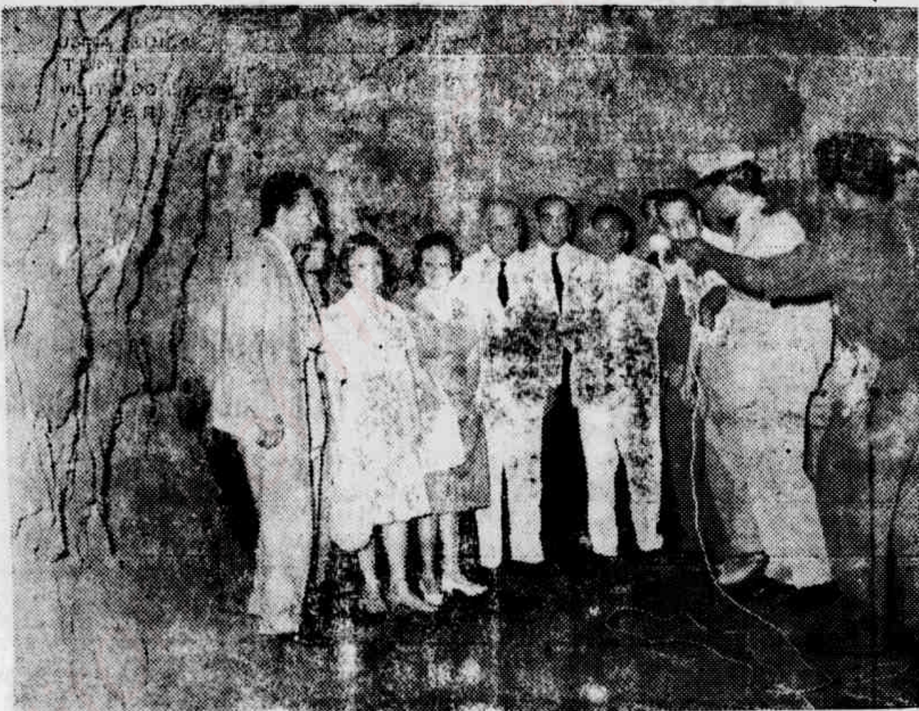
Aspecto da visita do sr. Governador do Estado Dr. Carlos Fernando Monteiro Lindenberg, às obras da Usina "Suiça"
