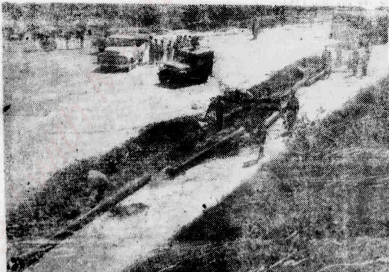
Trecho na BR - 31 da nova sub - Adutora de 10" exten- são: 1.300m
