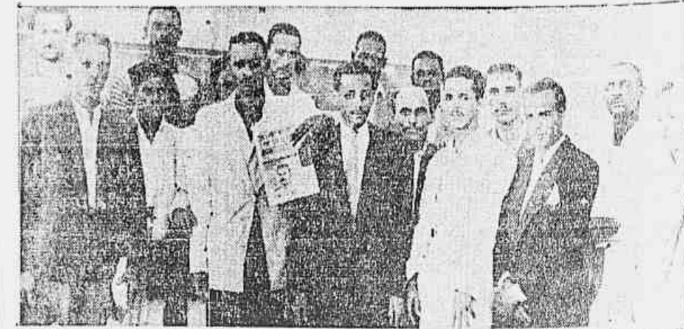
PARA PROTESTAR CONTRA O ATRASO DO PAGAMENTO NA OBRA QUE SE CONSTRÓI ÀR. Venezuela nº 53, sob a responsabilidade das Empresas de Construção Geras, elet em nossa redação uma comissão de trabalhadores da Construção Civil. A firma também não está pagando o aumento convulso através do Sindicato coletivo em que a classe está organizada e isto porque — diz eram-nos — a diretoria do Sindicato não se mette para defender os interesses que seus associados e nem sequer informou a corporação sobre os resultados do questionário — também nos também que trabalham até, em domingos e feriados, apesar de que a firma não se preocupa em fazer o pagamento com regularidade. Lutam ainda pela aplicação do disposto constitucional que assegura a remuneração do desano semanal. Constanham a comissão de trabalhadores Antenor Pinheiro, Germino Almeida, Liberato Alves Dias, Agenor Boia, Sebastião Aguiar, Agenor Coelho, Juvenil Borges de Andrade, Romário Pereira Ramos, Cláudio Morais, Givaldo Zanetti, José Maria, Nelson Furtado Moravcov, Irineu de Oliveira, Walter Fortes, Plínio Osório, Joazeiro Pinto de Souza e Ari Silva que aparecem na gravura falando ap' nossa redação.
